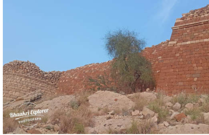
Till Kot Bastion wall
